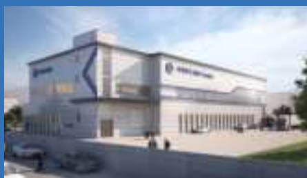
二次電池のR & Dセンター
